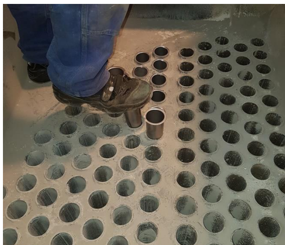
Montage i lodret konvektionspart
