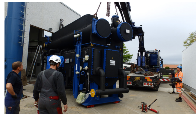
Indsætning af den 3,9 meter høje og 24 tons tunge absorptionsvarmepumpe.
