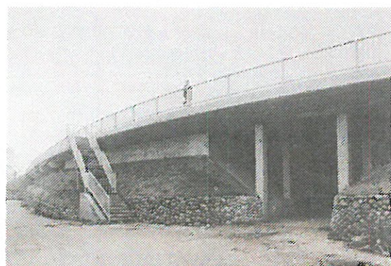
Broprojekt Søndergade, Varde - netop afsluttet.
