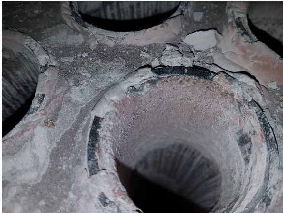
Foto visende belægninger i kedelrør
